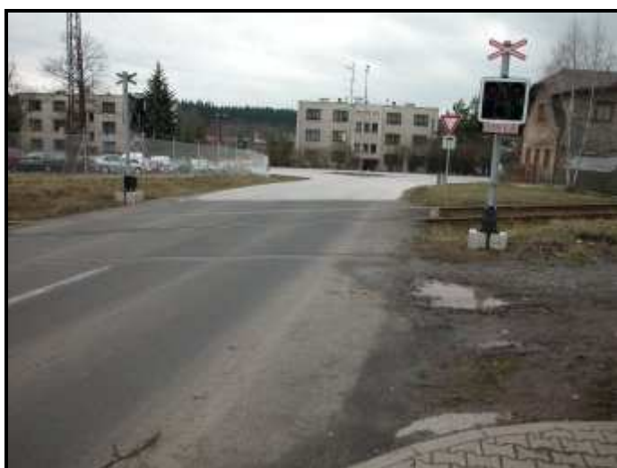
17 – Železniční přejezd na III/2936
