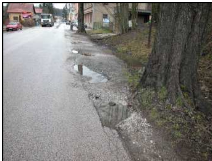
8 – Odvodnění do příkopu vlevo
