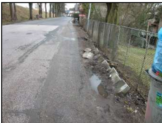
9 – Odvodnění příkop. žlaby vpravo
